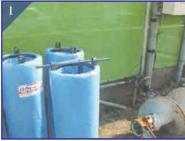
取付前のミルクトレールの金具に カンザシ筋を通した状態
