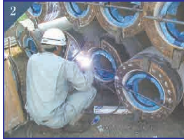
ミルクトレールのカンザシ筋を 杭頭部にしっかりと溶接する。 溶接が不可能な時は、番線で縛 るが切れるおそれがある。
