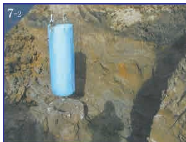
堀削重機で出来るだけ真上に引っ 張り上げる。
