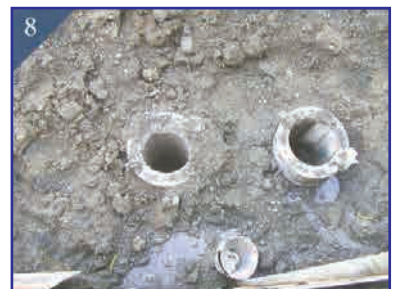
杭内部に確保された空間
