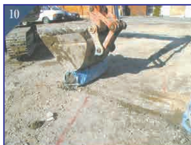
堀削重機でミルクトレールを潰す。
