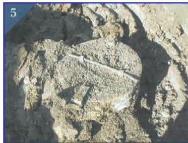
堀削で現れた杭頭部 この時ミルクトレールの金具を 破損しない様注意する。
